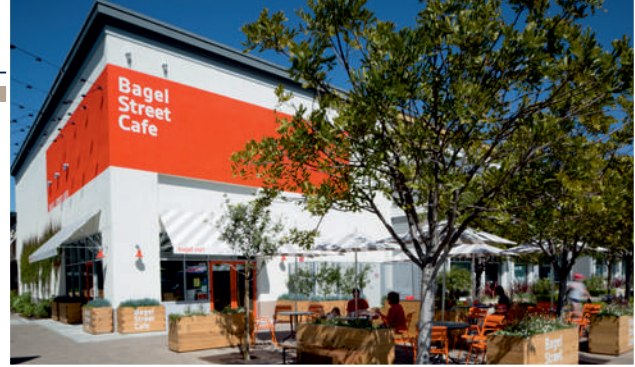
Alameda South Shore Center, 523 South Shore Center West, Alameda, Kalifornien, USA Baujahr: 1958; 2002-2009 Mietflächen in qm: 55.310 Vermietungsstand: 87%
