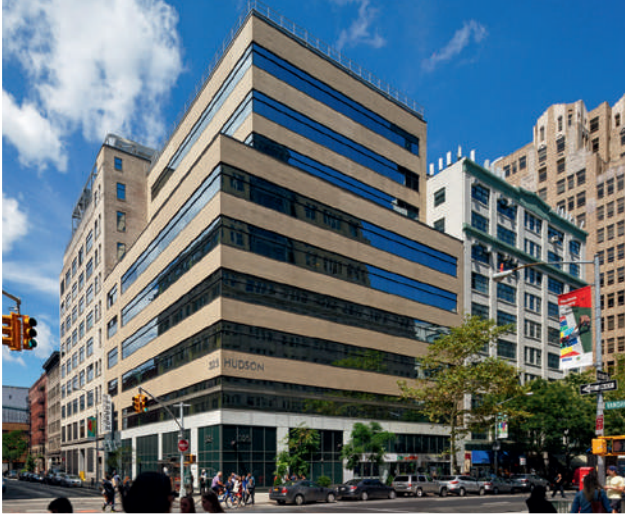
Bürogebäude 325 Hudson Street, 325 Hudson Street, New York City, New York, USA Baujahr: 1930/1965 Mietflächen in qm: 22.427 Vermietungsstand: 71%
